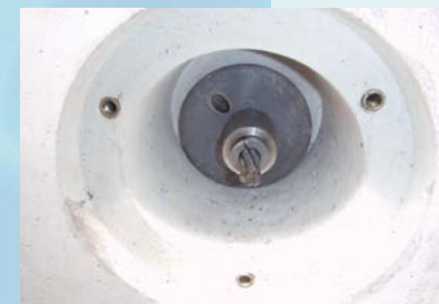
定着状況（端面定着部）
