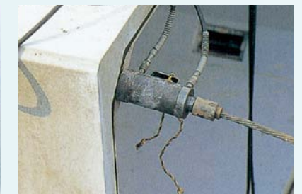
ジャッキによる緊張
