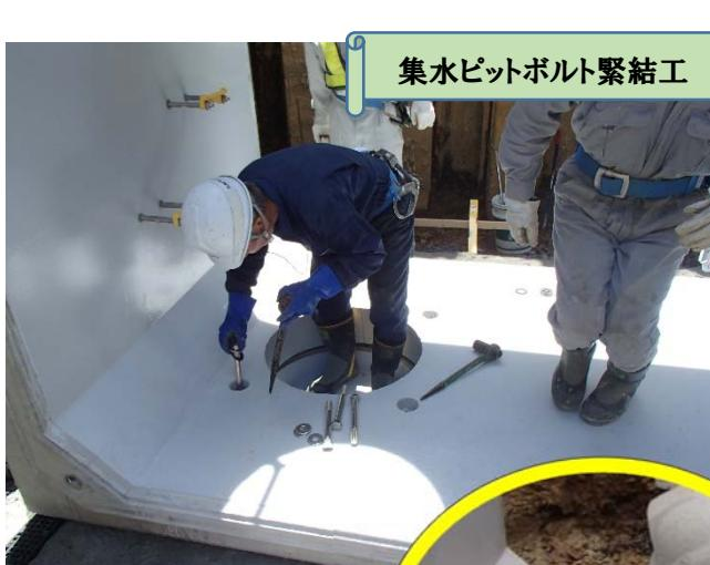
1. ボルト緊結はラチェットレンチを使用し、対角の2箇所を同時に締め付ける。
