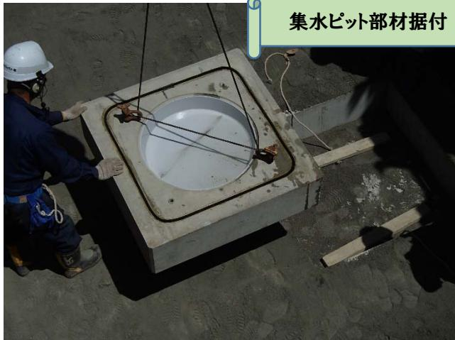
1. 設置面から水平に据え付ける。
