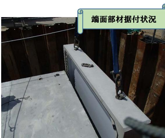
1. 端面部材は、墨出し位置を目安にして、本体部材に嵌め合わせて据え付ける。
