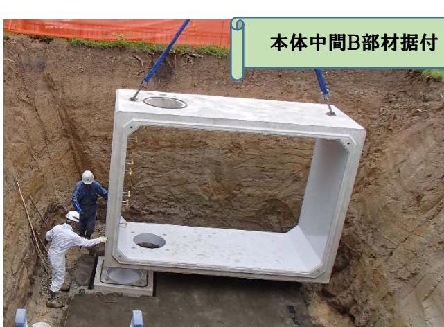
1. 中間ボックスB部材と集水ピット部材を緊結するため、開口部を目安にしておおまかに位置を合わせる。
