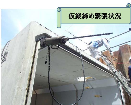
3. 本体部材は据え付けを置いただけでは完全に嵌め合いされず、施工長が伸びることあり、又、全部材を一度に縦締めできない場合など、必要に応じて本体部材設置終了後、仮縦締め緊張工を行う。
