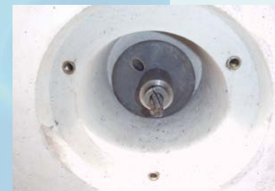
定着状況（端面定着部）
