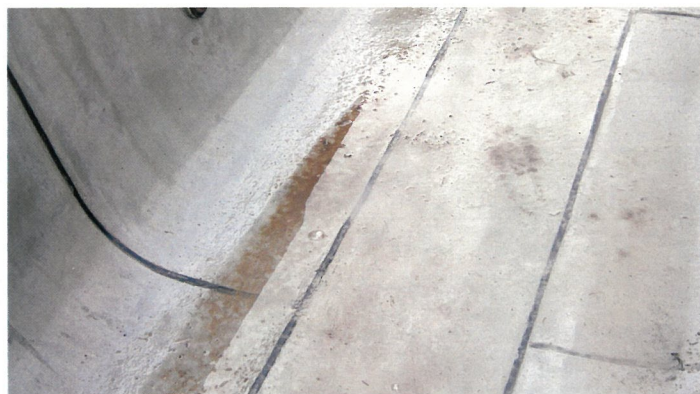
⑤ 水路面内モルタル仕上げ補修
