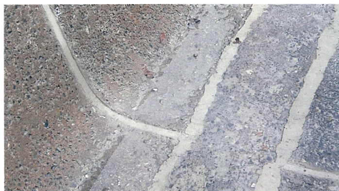
② 目地部モルタル補修
