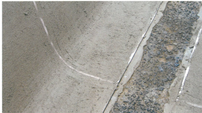
④ 水路面内モルタル補修
