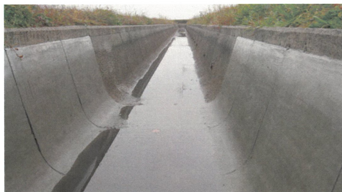
⑥ 手前部分補修完了状況
